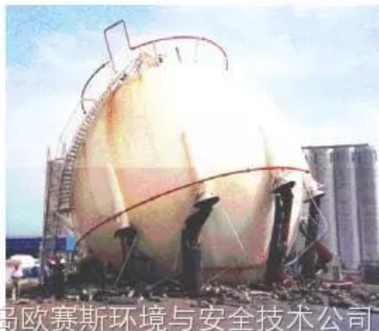
支撑结构被侵蚀
