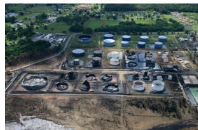
大火过后的设施损坏状况
